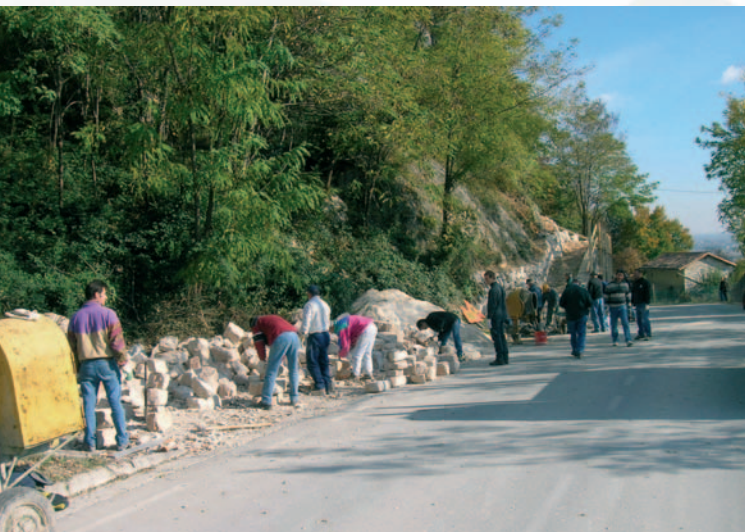
Cittadini di Caneva al lavoro per il recupero di un muro in sasso. Caneva inhabitants working to reclaim a stone wall.
